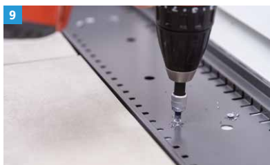
9 Niedrige und barrierefreie Türanschlüsse lassen sich mit der flachen Drainrinne AquaDrain® VARIO regelgerecht herstellen. Sie wird auf dem Tragprofil fixiert – entweder durch Verschrauben oder mit DiProtec® FIX-MSP.
