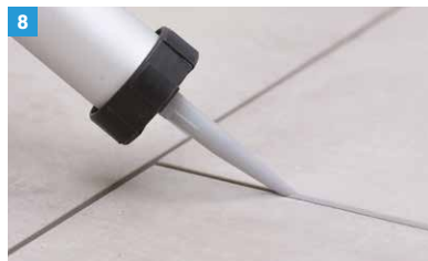
8 Soll der Belag mit geschlossenen Fugen ausgeführt werden, kann dies mit der Spezialfuge MorTec® SOFT erfolgen. Da bei geschlossenen Fugen die Entwässerung über die Oberfläche erfolgt, ist auf ausreichendes Belagsgefälle ist zu achten.
