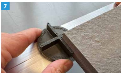
7 TerraMaxx® RS selbstklebende Fugenkreuze fixieren den Plattenbelag auf den Tragprofilen.
